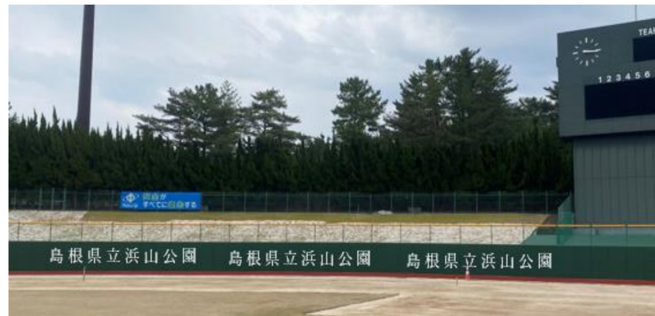
【広告掲出イメージ図】 区画 A 外野ラバーフェンス
